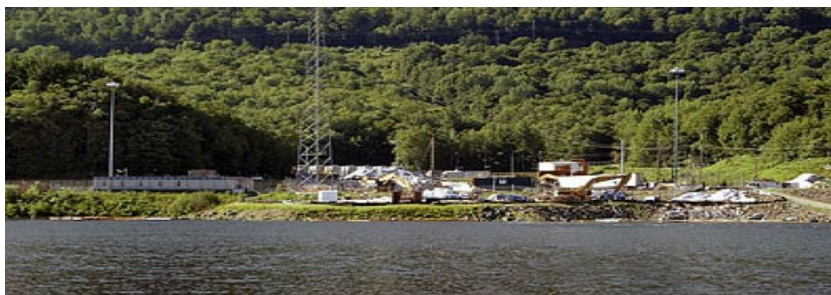
Centrale di Yankee Rowe
