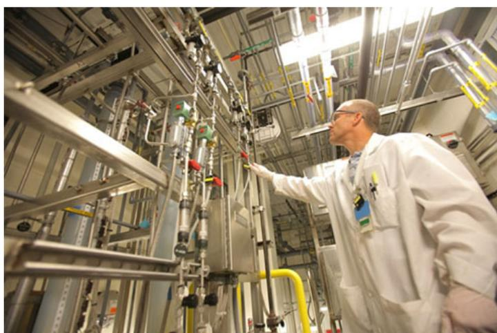
Fig. 8 - Impianto di diluizione (downblending per la conversione dell'Uranio
