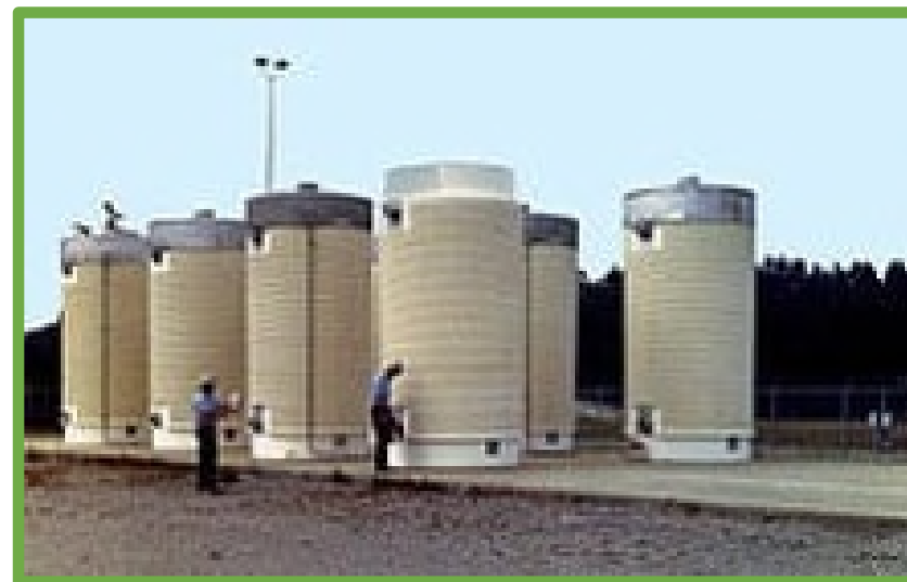
Cask per trasporto e stoccaggio dei canister di rifiuti vetrificati
