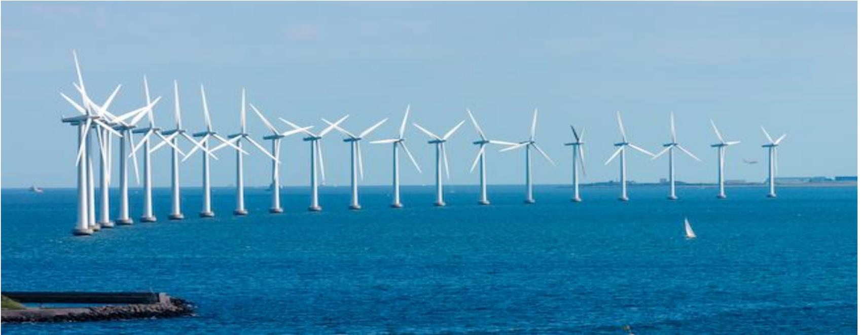
Il progetto di Beleolico intende costruire inizialmente 10 turbine off-shore con una potenza nominale di 3 MW ciascuna per una produzione annuale prevista di 80 GWh [fattore di carico:  $(80.000:8760) : 30 = 30\%$ ].
