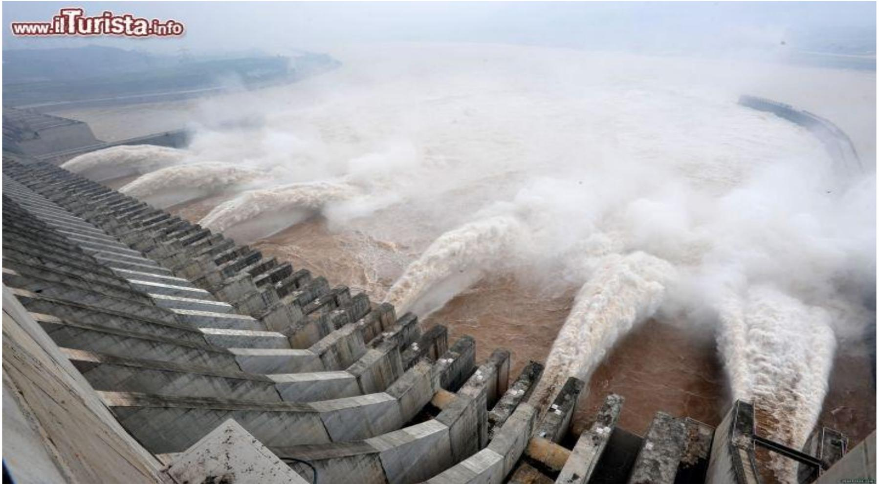
**La diga delle Tre Gole, Cina.** Con la sua capacità di 22.500 megawatt e 98,8 terawattora generati ogni anno, è **l'impianto energetico più potente al mondo**. Si tratta di una centrale idroelettrica alimentata dalle acque del fiume Yangtze, nella provincia di Hubei.
